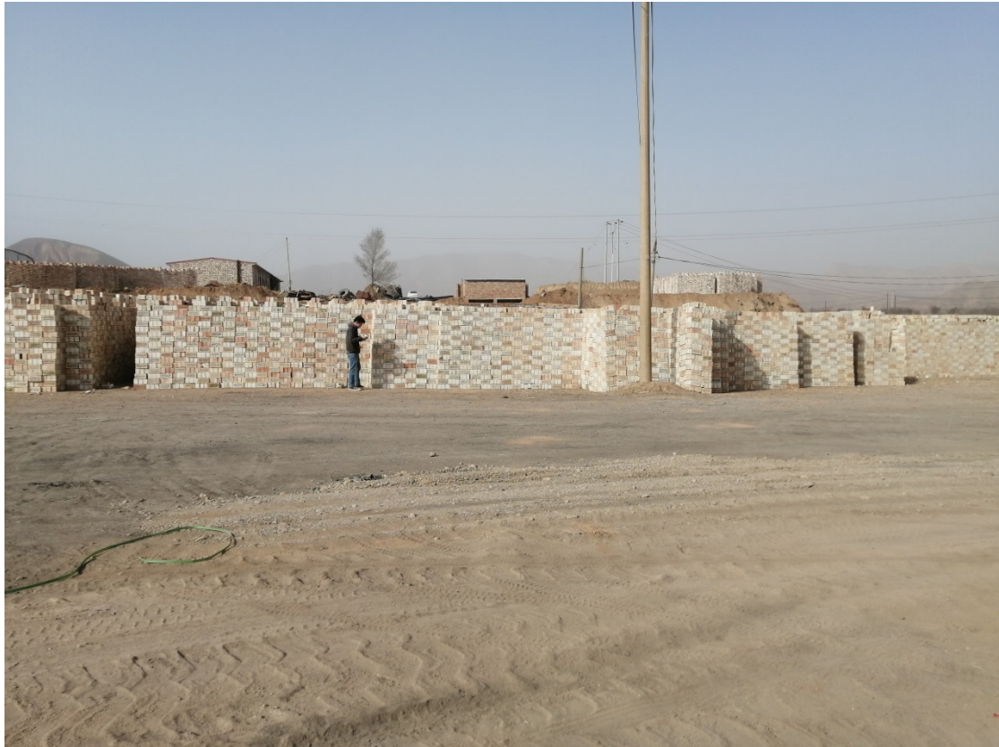
照片 1-5 工业场地（堆砖场）（镜向西）
